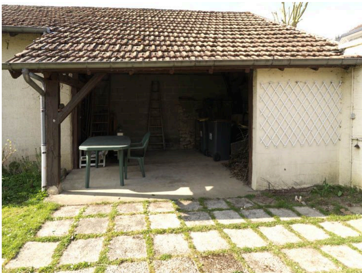
Atelier du charpentier Canteau, appentis.
