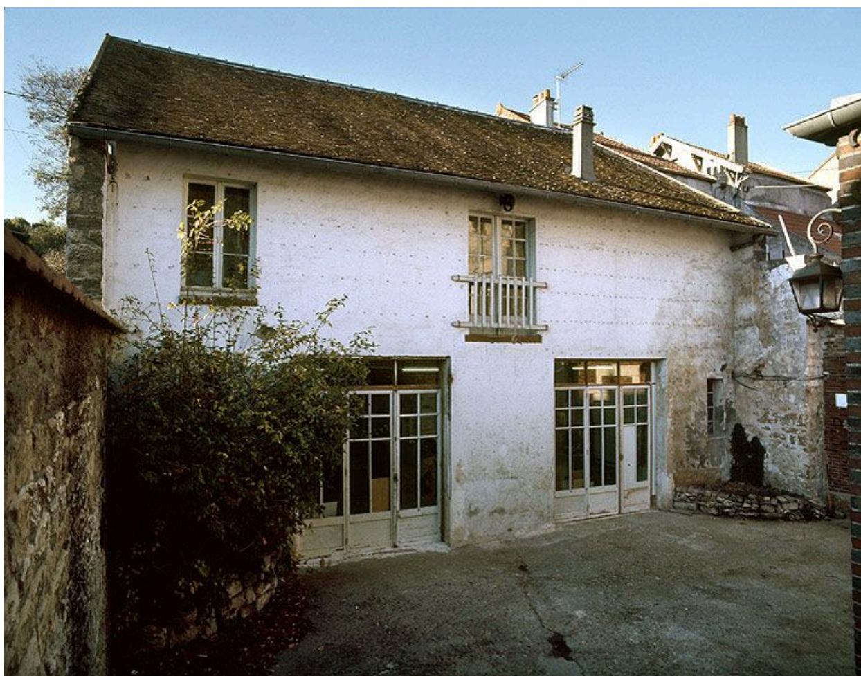
L'ancienne grange devenue commun de la maison.
