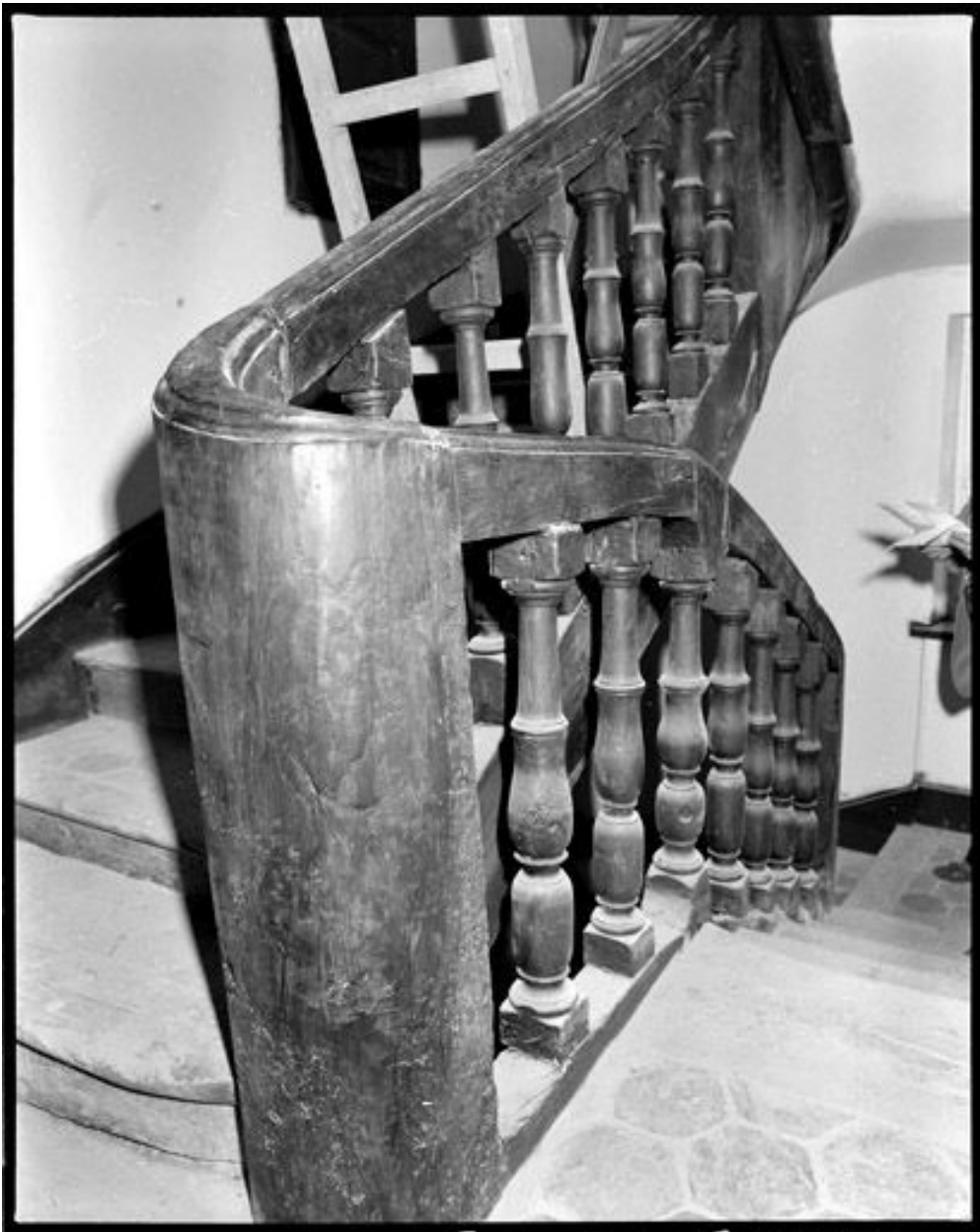
Maison, Cloître Notre-Dame (rue du) 11. Rampe à balustres en bois en double poire de l'escalier.
