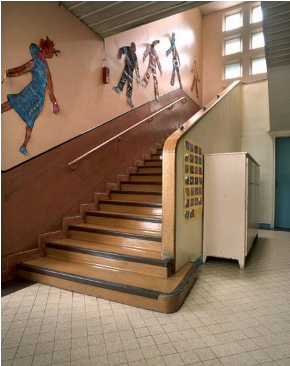
Groupe scolaire Joliot-Curie, rue Irène Joliot-Curie. Julien Heulot (architecte communal). Vue intérieure du hall, départ d'escalier.
