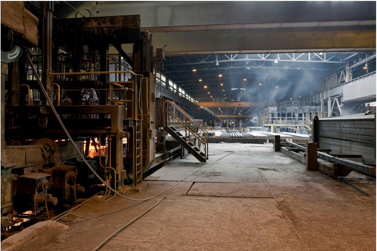
Halle à billettes, vue d'ensemble. (réf. Département Seine-et-Marne : IVD77_2013_77_00248_NUCA)
