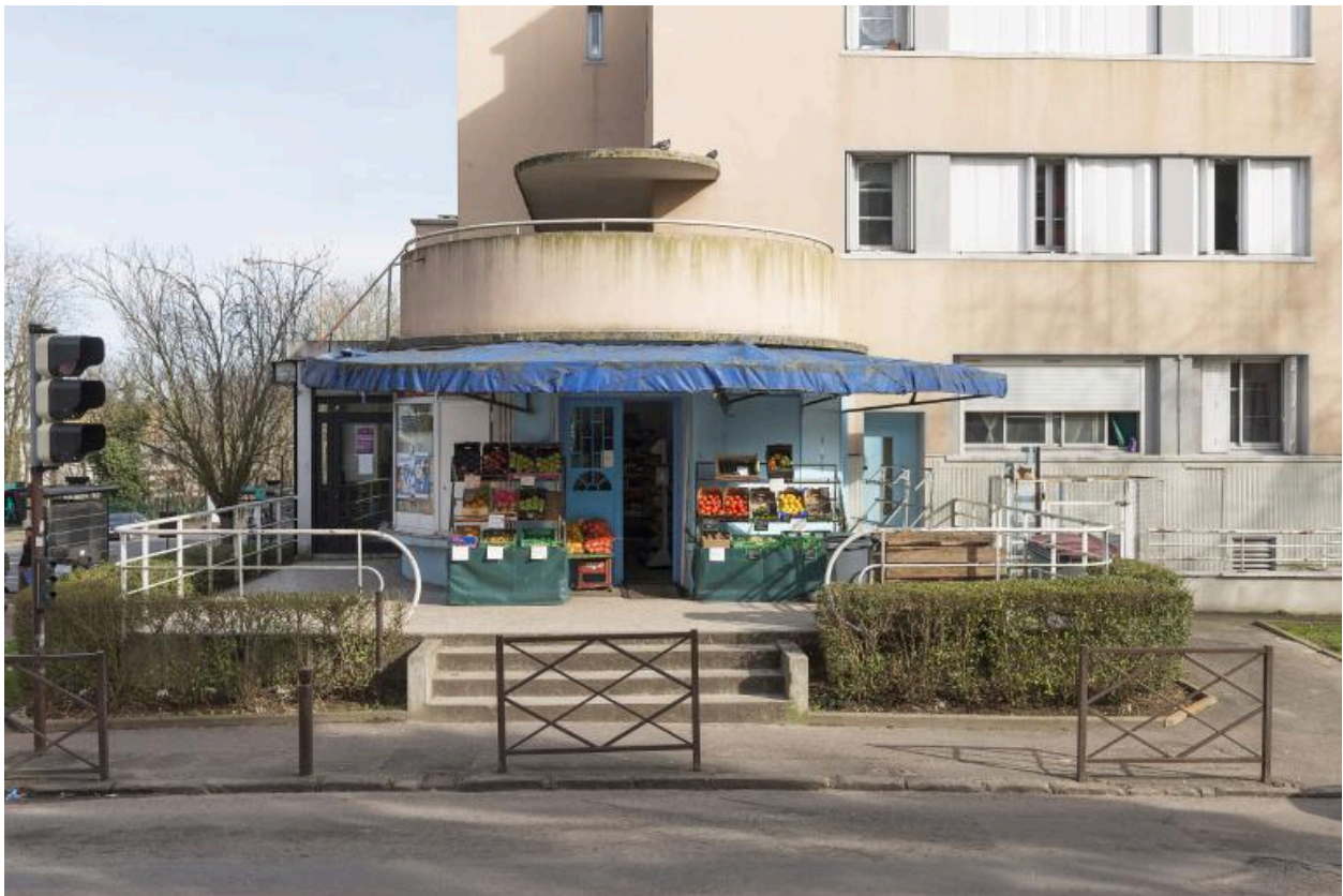
Vue du 1 rue du Général Duval
