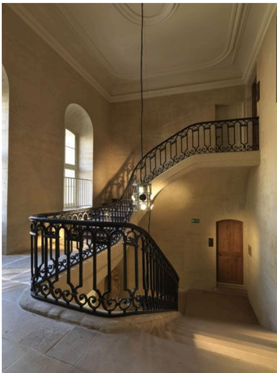
La dernière volée de l'escalier.
