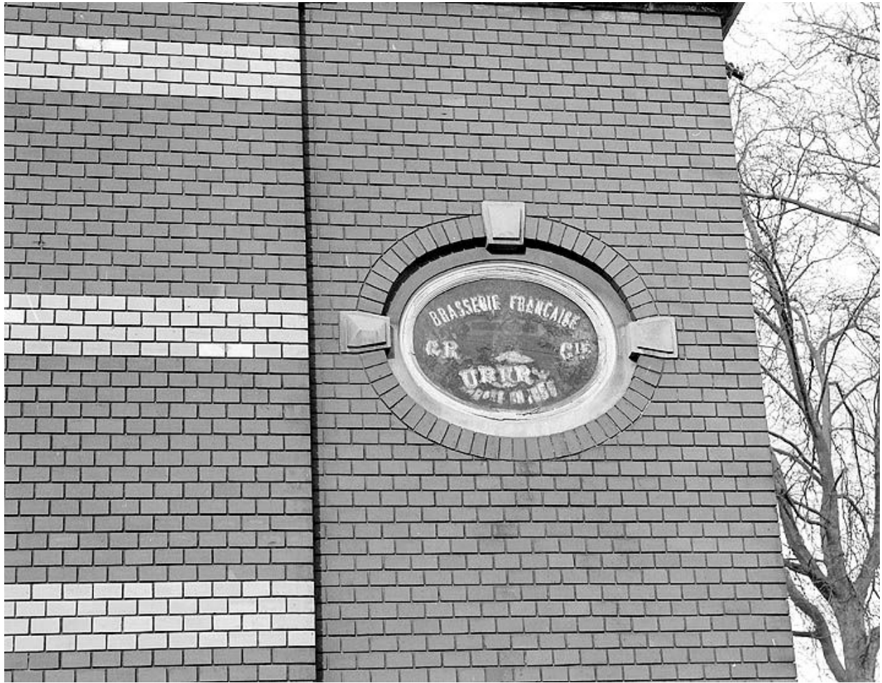
Bâtiment des bureaux, détail de l'élévation latérale : plaque avec la raison sociale de la brasserie. Photographie avant destruction, 1989. (Ministère de la culture, Inventaire général. 89SG687X)
