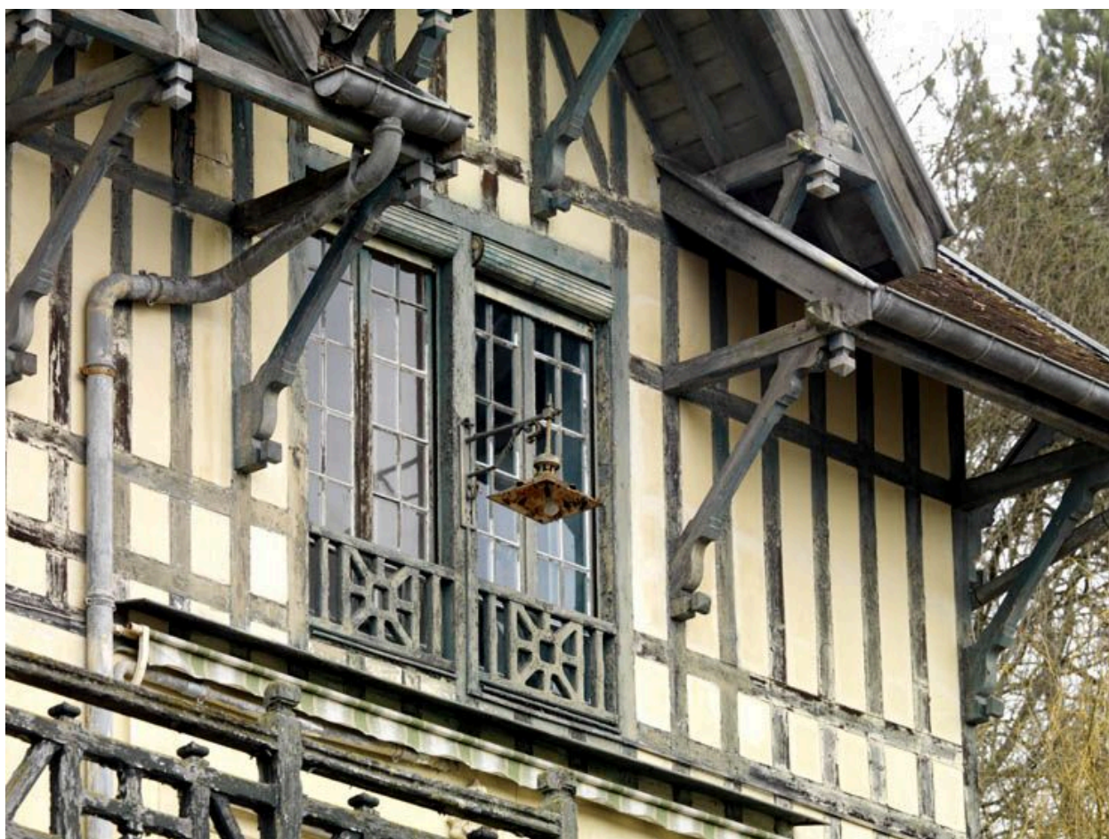
Villa des Fontaines-Dieu, travaux de serrurerie et construction métallique exécutés par l'entreprise Oudiou de 1896 à 1910.
