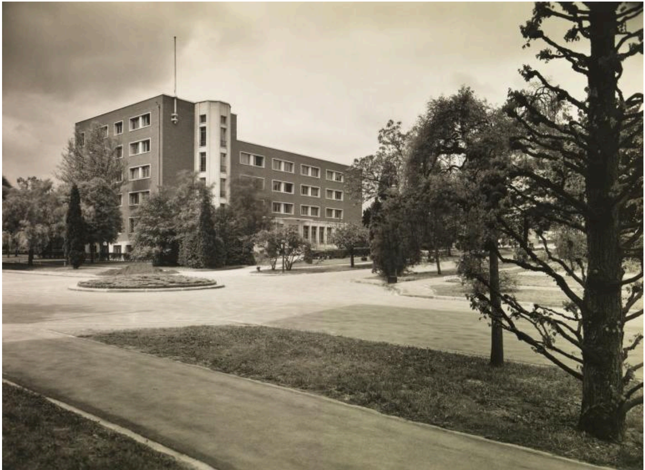
Vue d'ensemble prise du nord-est. Vers 1955. Photographie. Kollar (photographe). CIUP, centre de valorisation du patrimoine, P/TP-B33-1103.
