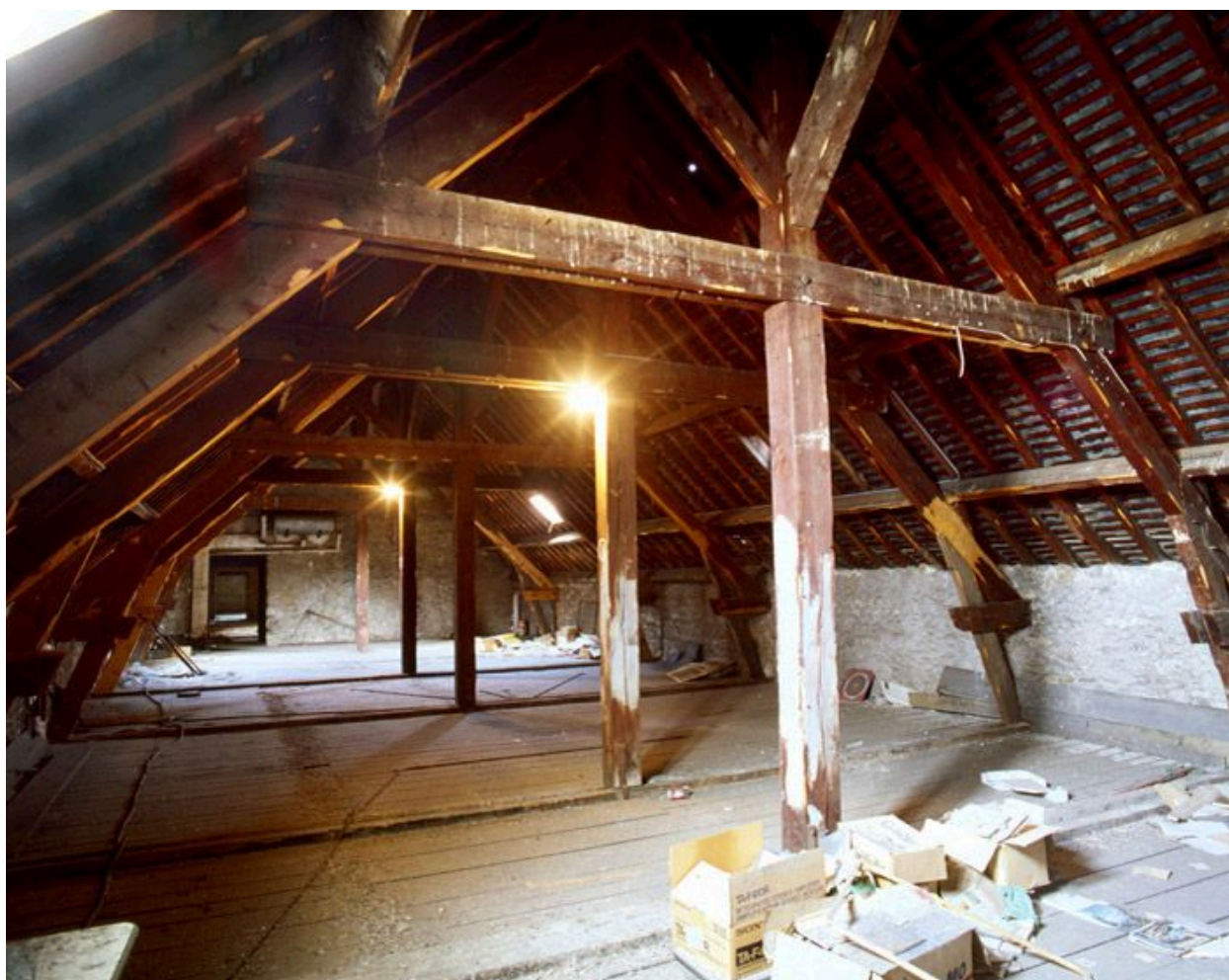
Vue intérieure : la charpente.
