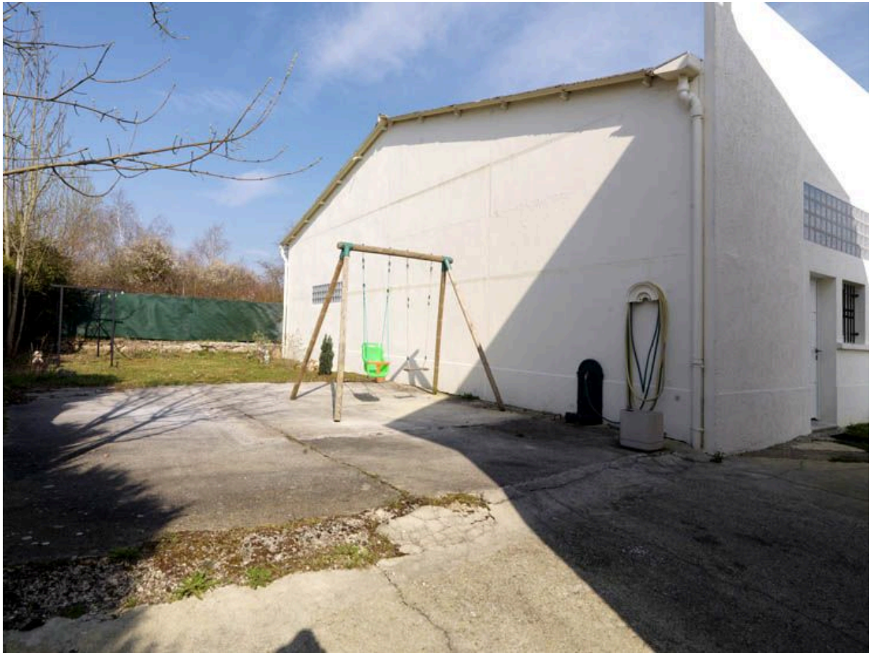
Mur pignon de l'ancien atelier d'usinage.
