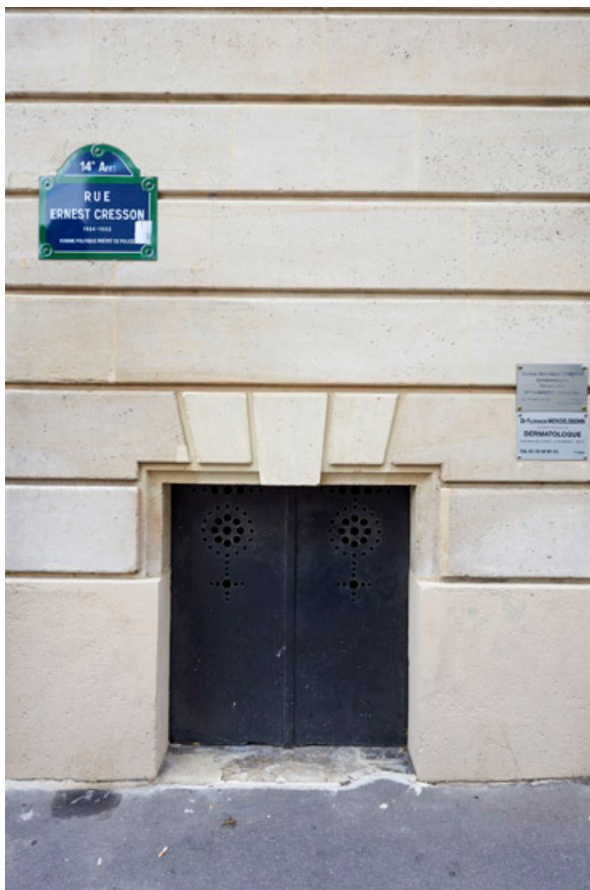
Vue de l'entrée de cave, côté rue Ernest Cresson.
