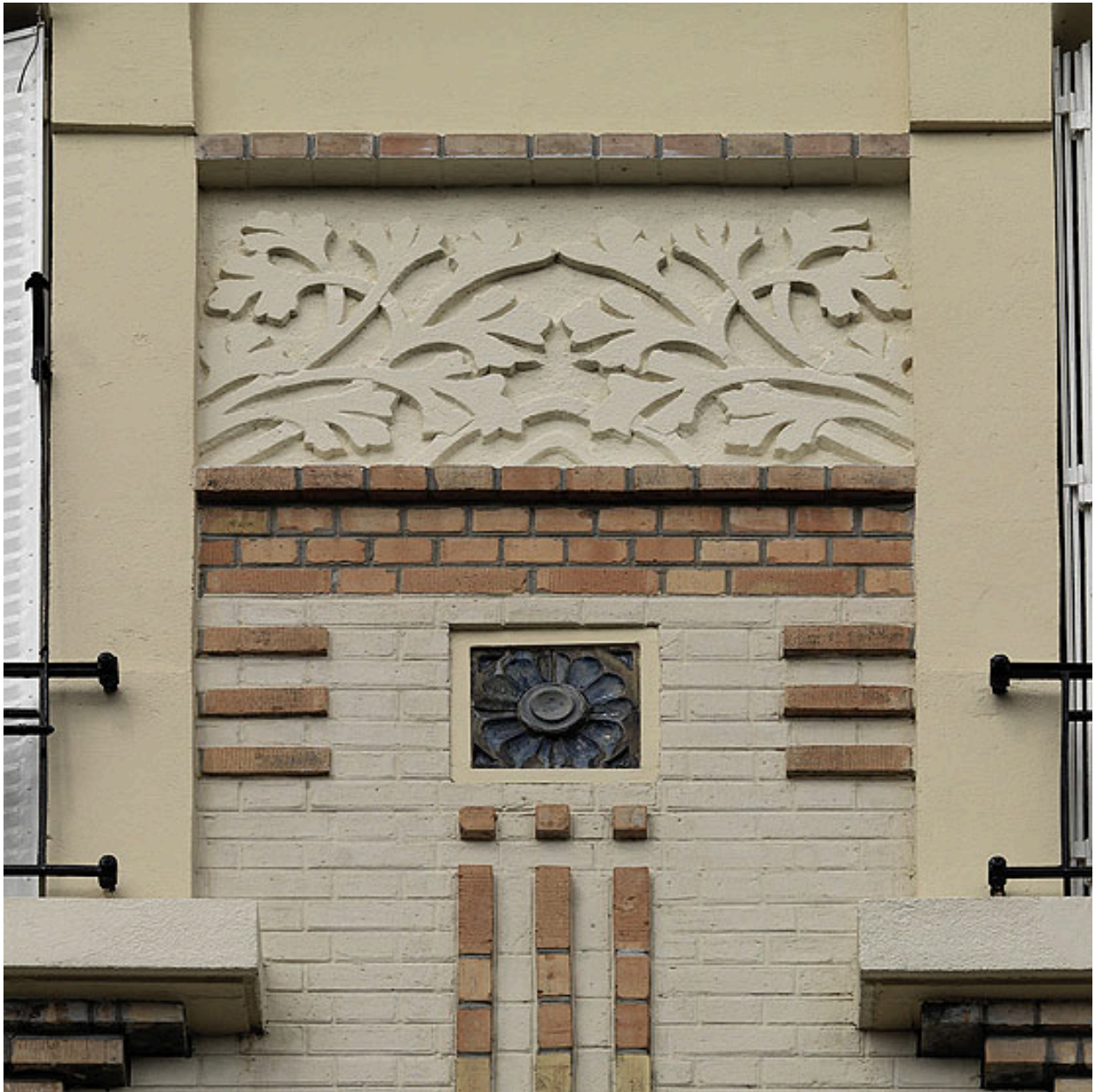
Détail au deuxième étage, entre les deux baies centrales : panneau décoratif de béton orné de branches de végétaux
