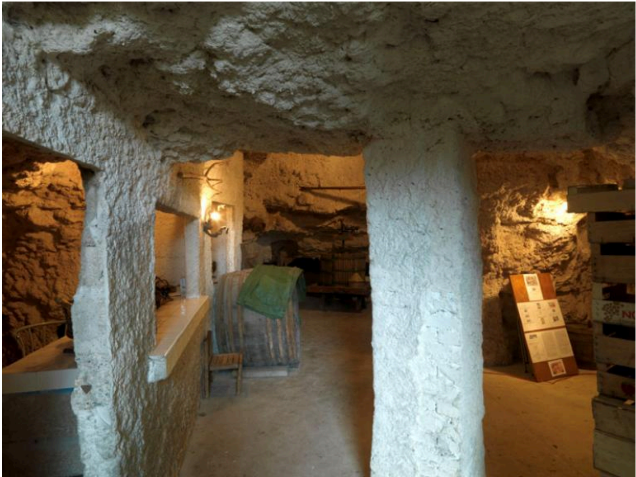
Ancien bar de la discothèque, revêtement en ciment projeté.
