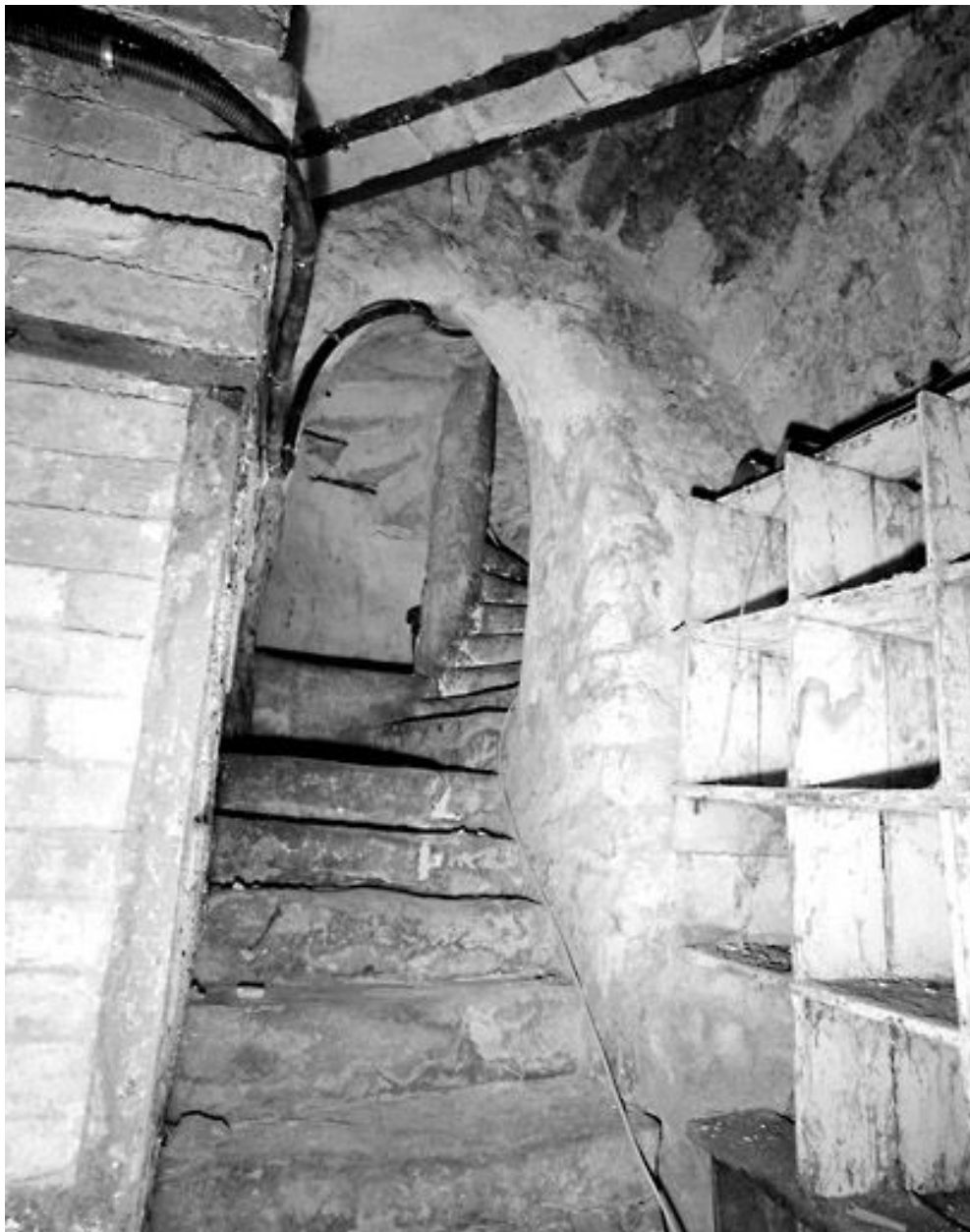
La cave du 18-20, rue Paul-Doumer : l'accès d'origine et le départ de l'escalier en vis desservant les niveaux d'habitation.
