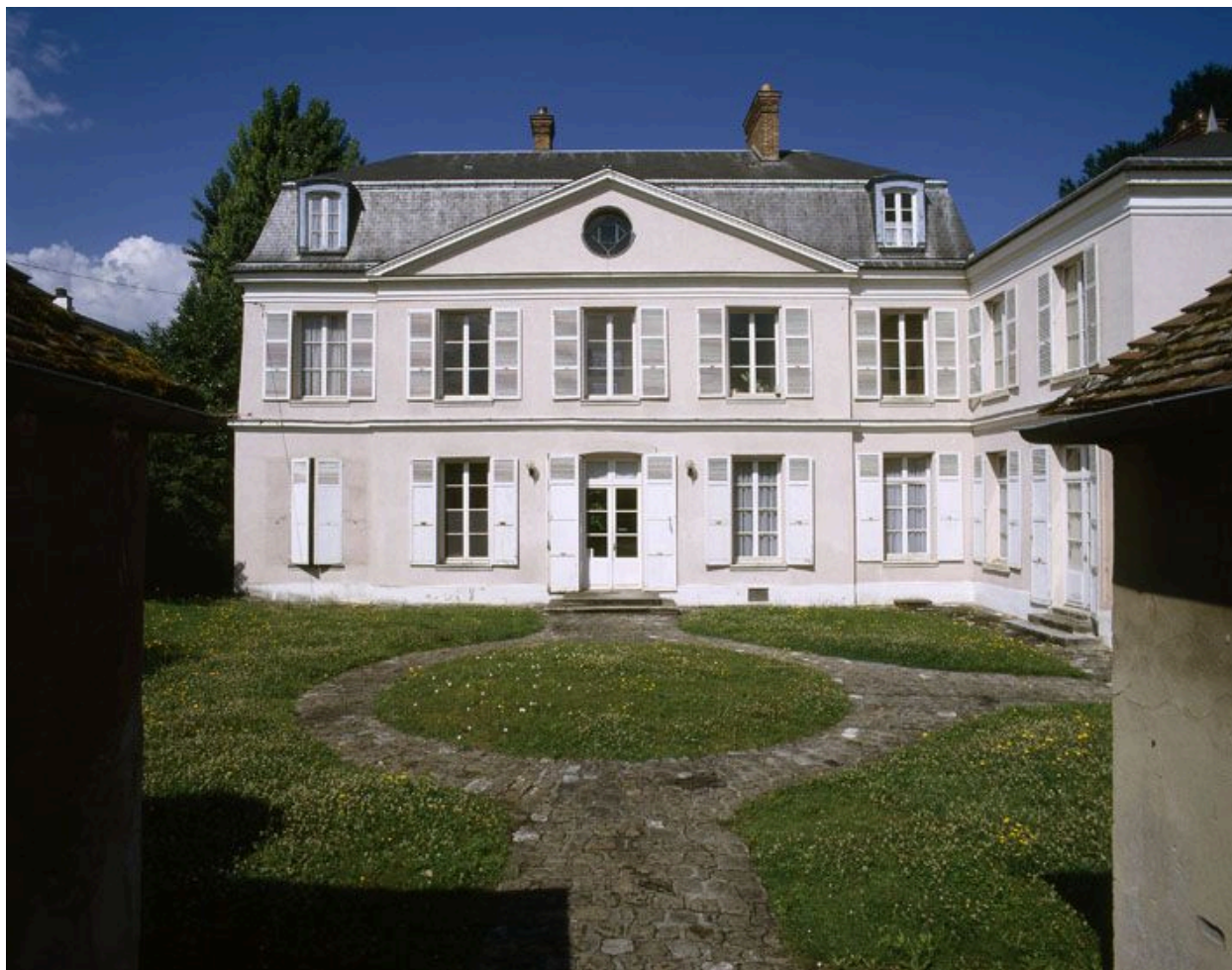
La façade antérieure.
