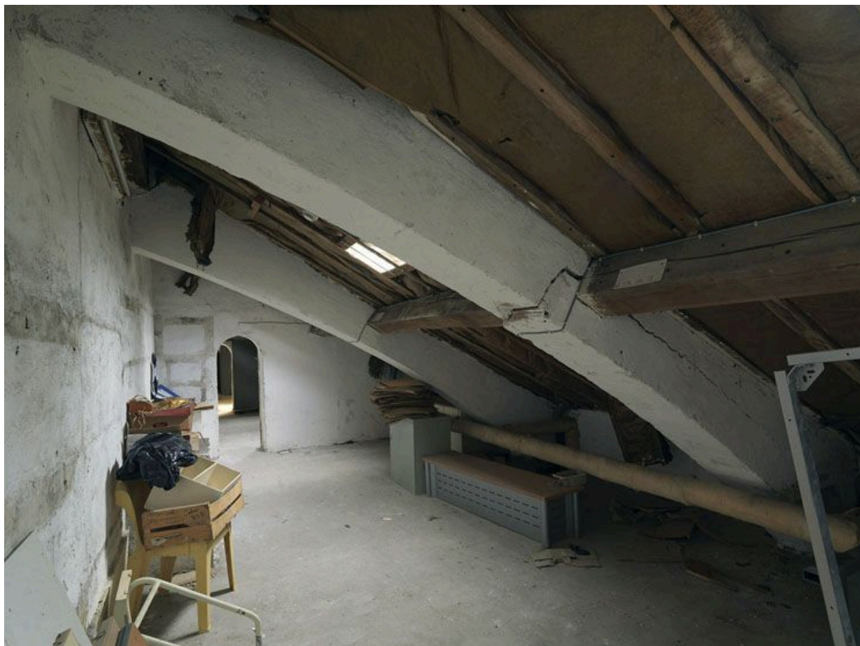
Vue des combles (côté nord).
