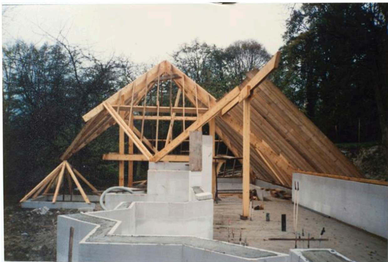
Vue de la charpente en cours de montage.
