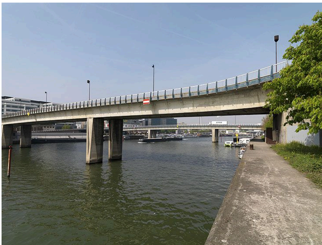
Ivry-sur-Seine, Charenton-le-Pont. Pont Nelson-Mandela. Vue d'ensemble d'un des deux ponts.
