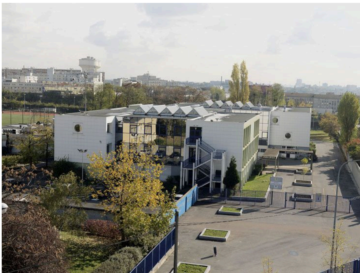
Collège Gustave Courbet, 101 boulevard Henri-Barbusse. Vue du lycée côté cour.
