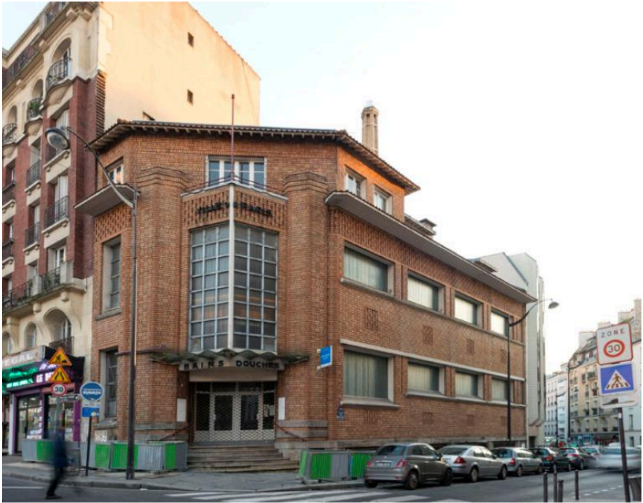
Vue générale des bains-douches de la rue Petitot.
