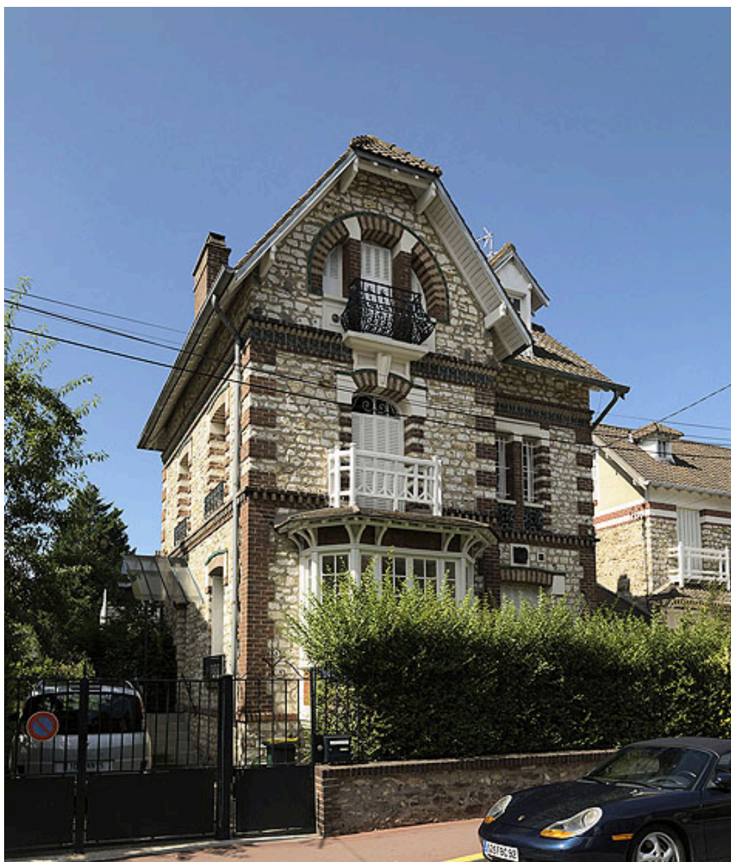
Vue d'ensemble de la maison.
