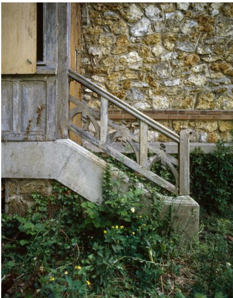
Détail de l'accès vers l'entrée.
