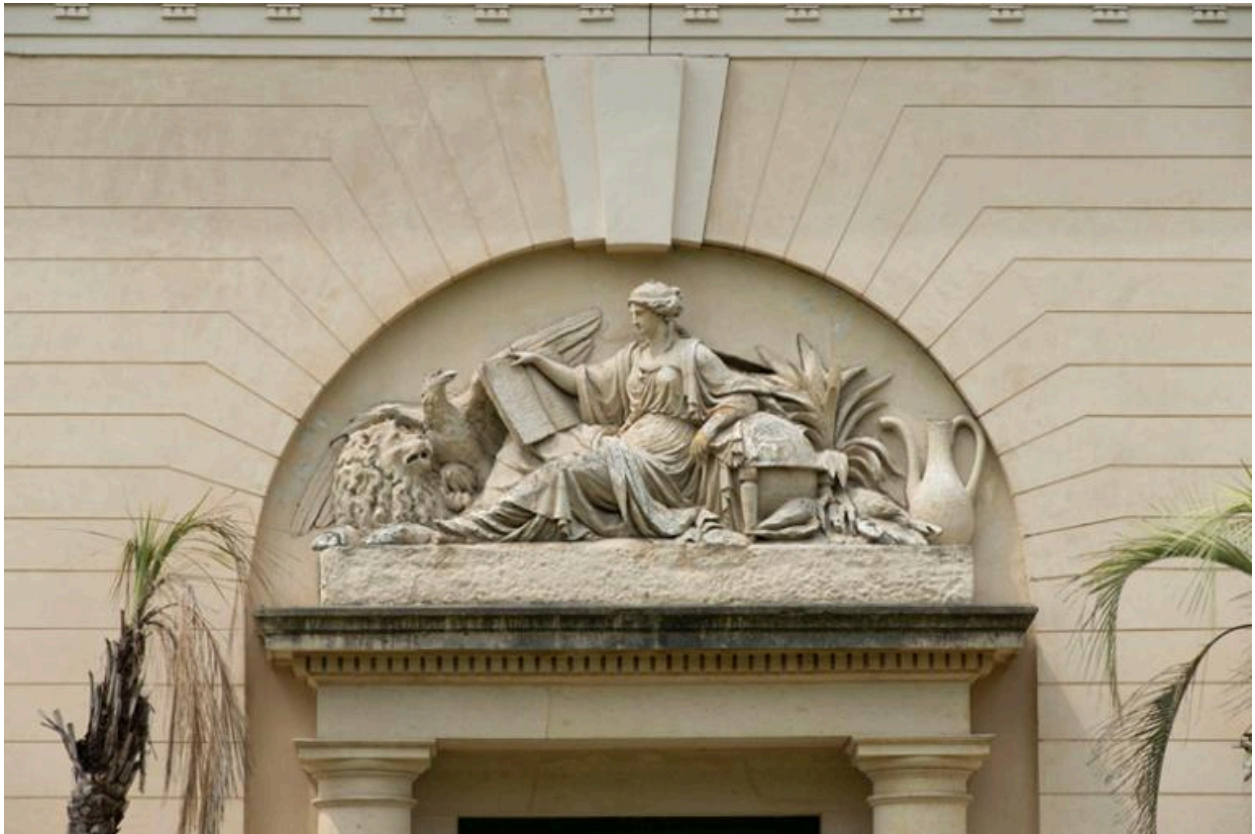
Elévation antérieure, avant-corps, détail du haut-relief sommant la porte d'entrée.
