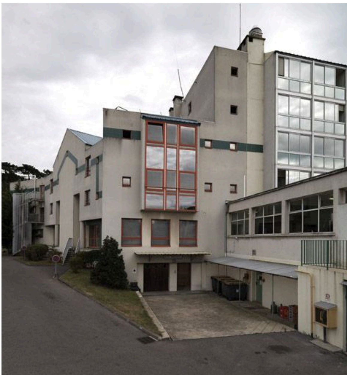
Façade latérale nord-ouest (correspondant à l'extension de 1989).
