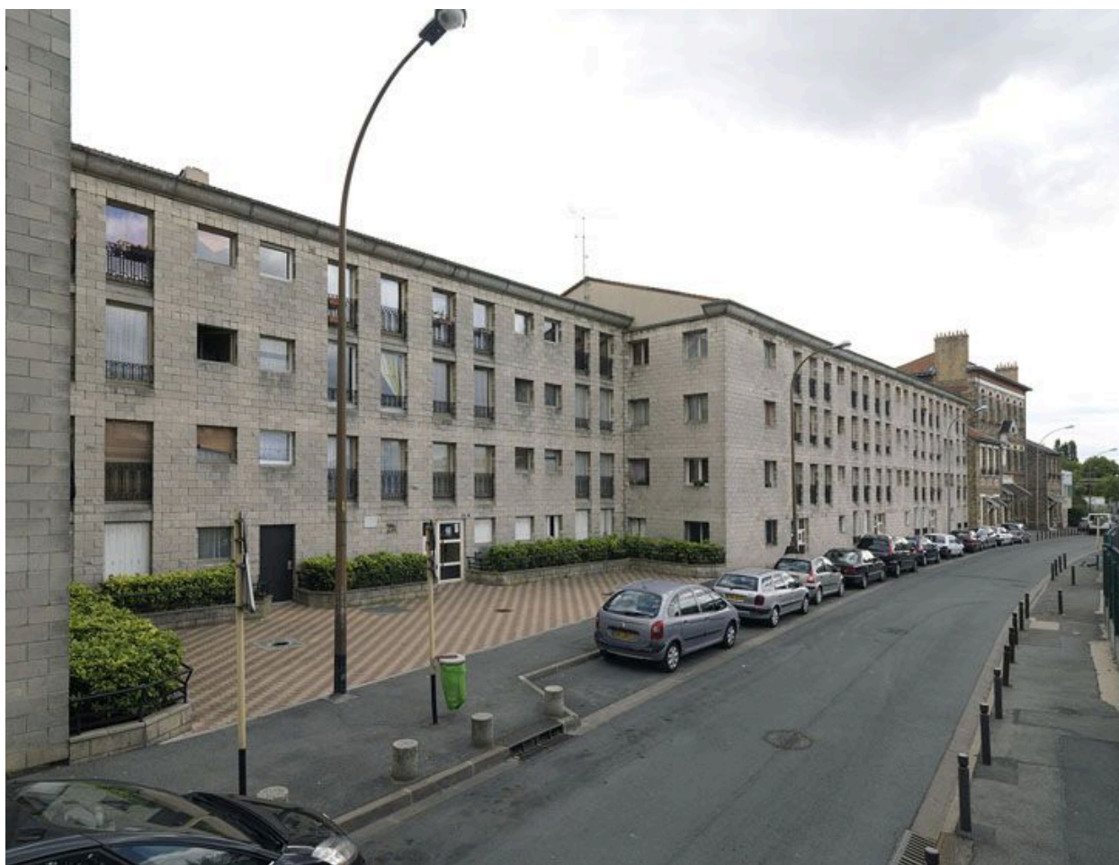
Cité Paul Eluard. Vue d'ensemble de la cité, rue Jean-Jaurès et rue de la Fraternité.
