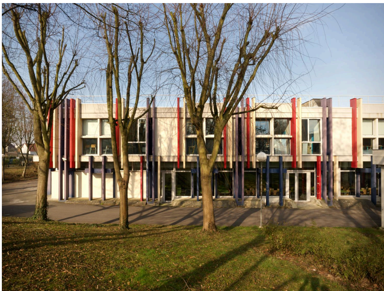
Vue générale du lycée depuis la cour.
