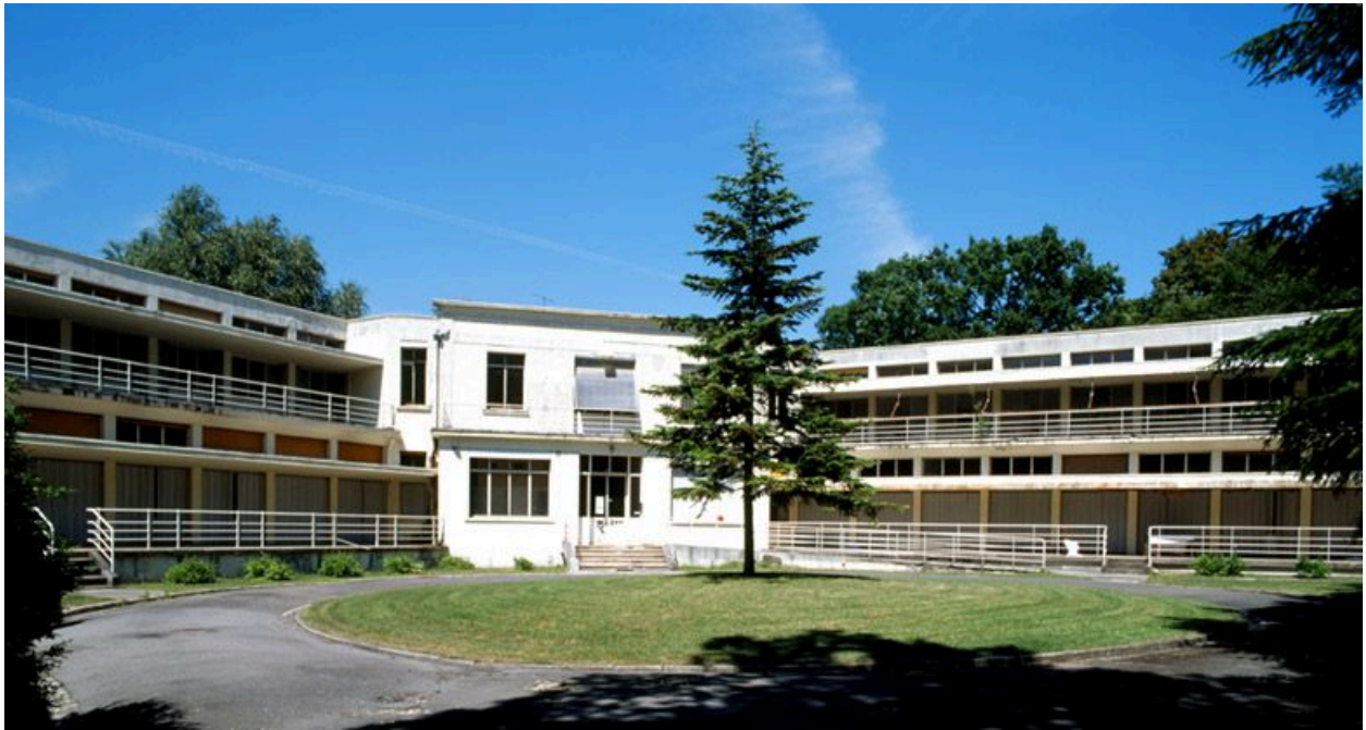
Le sanatorium, vu du sud.
