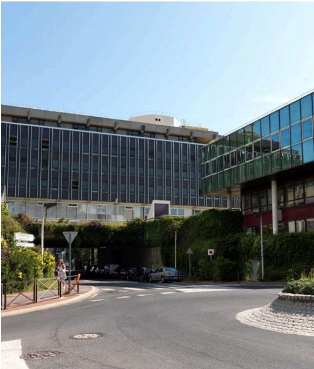
Vue de l'avenue de la Poste au niveau de son passage sous la dalle.
