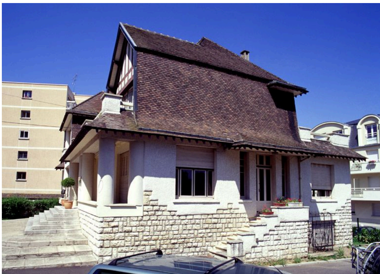
Elévation latérale sud.
