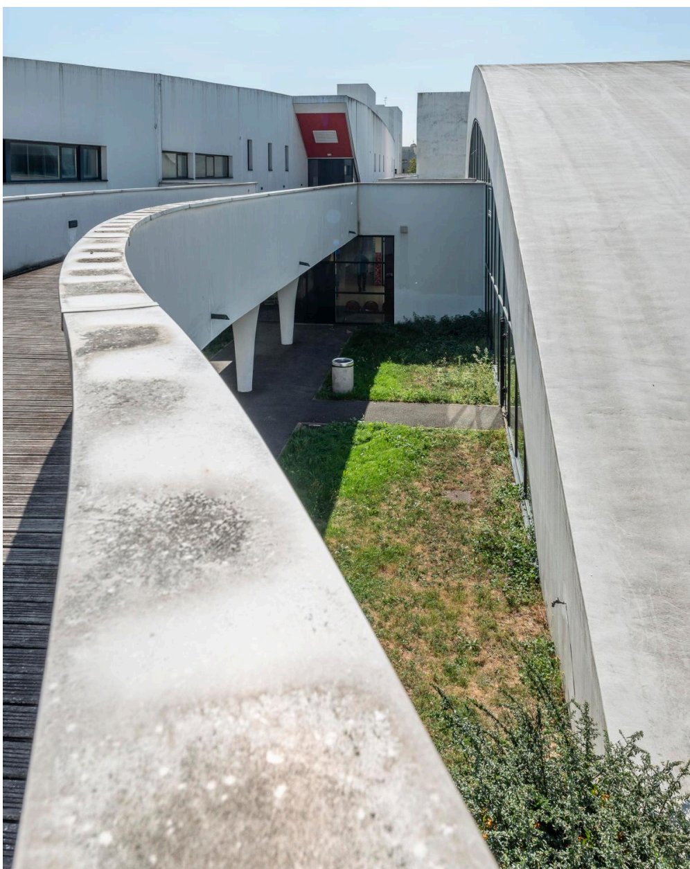
La rue intérieure et le péristyle.
