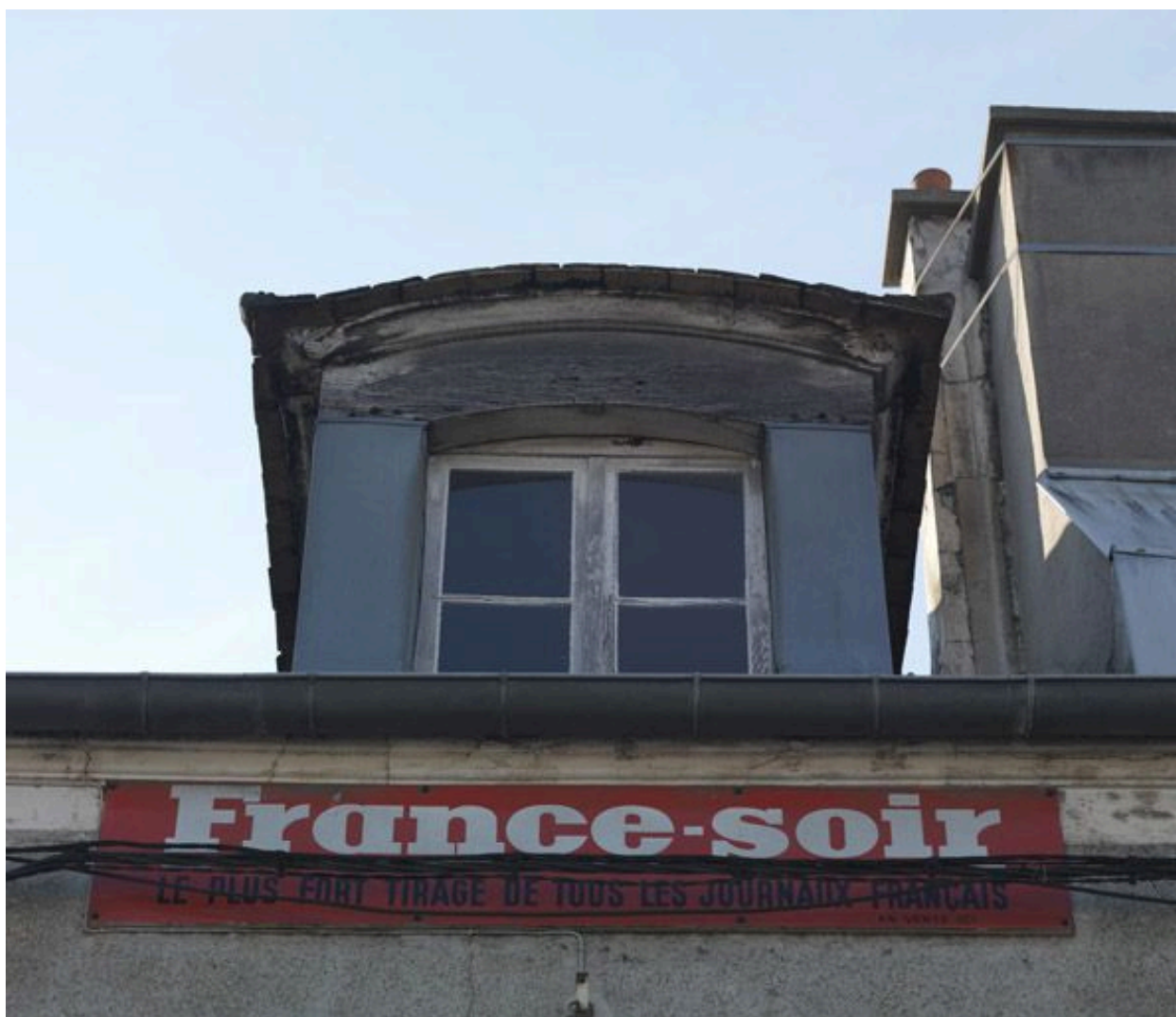
Lucarne sur le toit de la maison, 30 place de la République.
