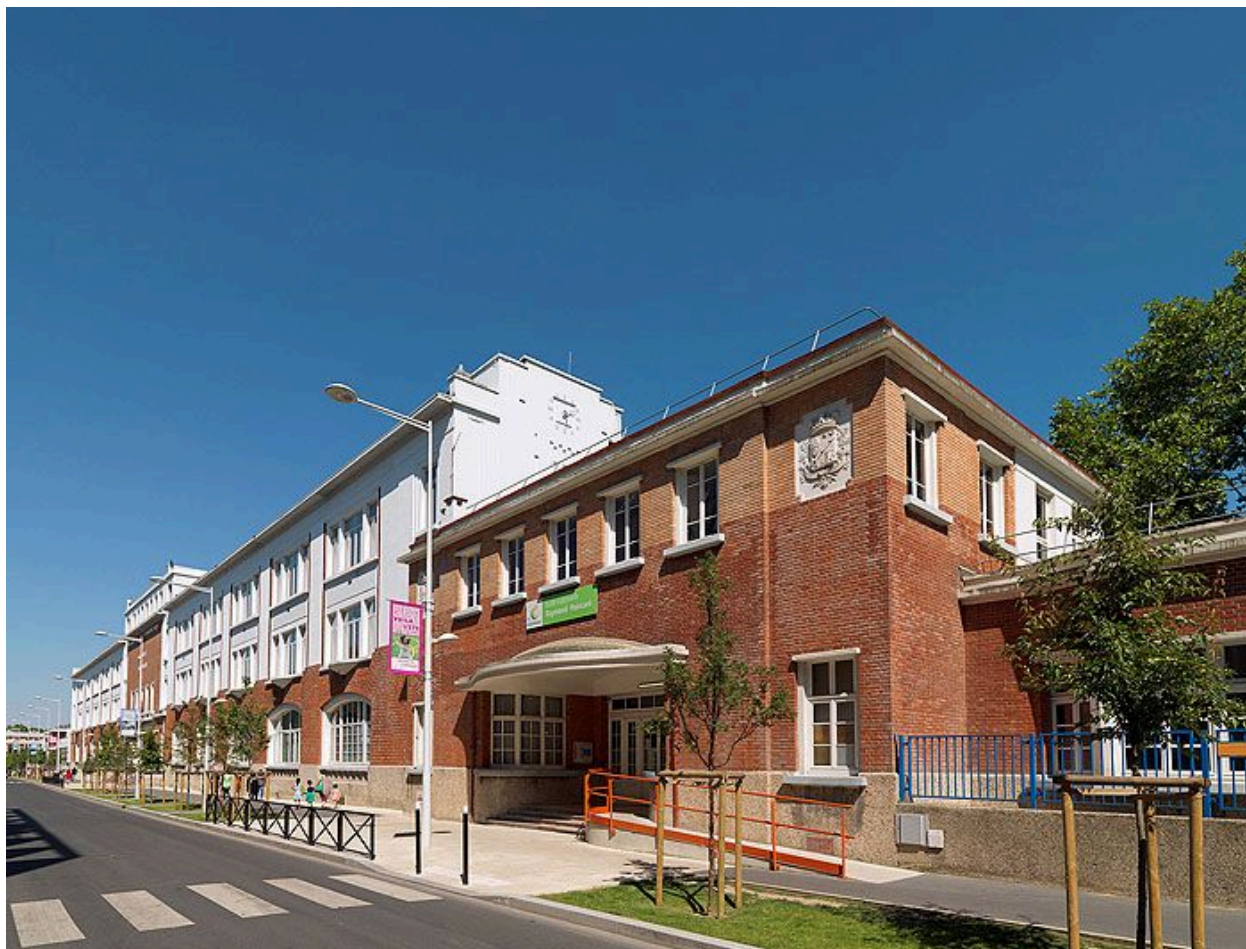
93, Courneuve (La), collège Raymond-Poincaré, avenue de la République. Vue perspective de l'ensemble de la façade sur l'avenue.
