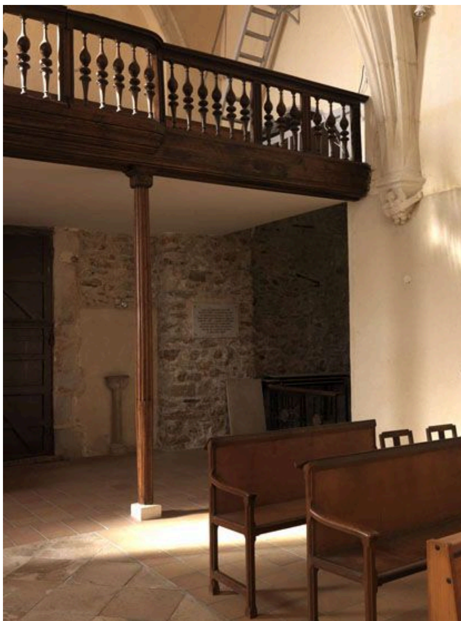
Vue d'ensemble de la table utilisée comme garde-corps de la tribune.
