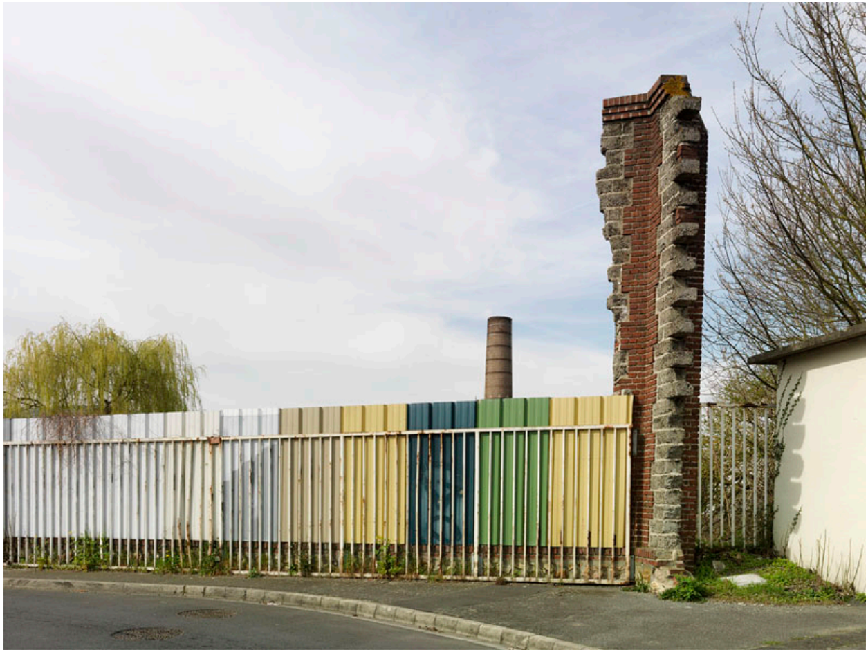
Asnières-sur-Oise. Clôture temporaire et vestiges du mur d'enceinte de l'ancienne usine Delacoste puis Vulli. Au fond, l'une des cheminées de l'usine.
