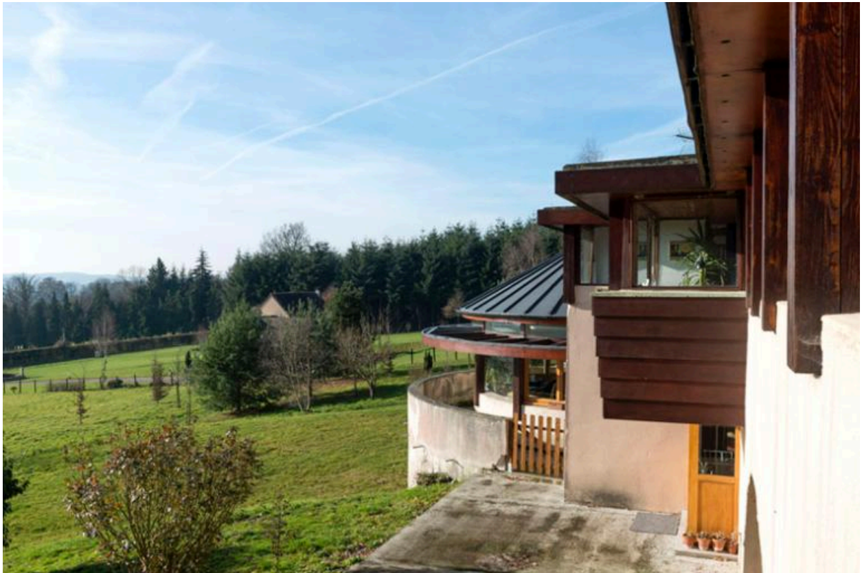
Vue latérale de la façade.
