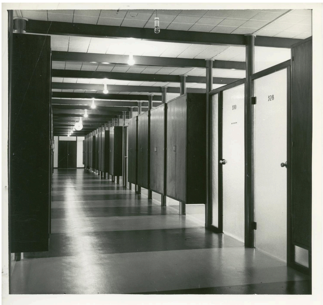
1961, le siège d'Air France ou bâtiment 363.
