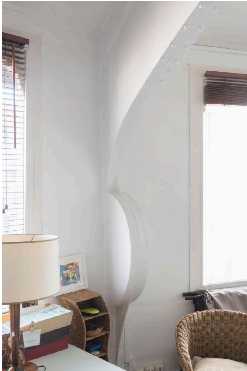
Détail d'un élément de la charpente métallique à l'intérieur d'un des ateliers (M. Mathieu) de la Rotonde
