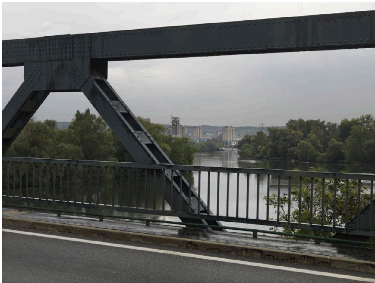
Poutres en treillis et garde-corps du pont.
