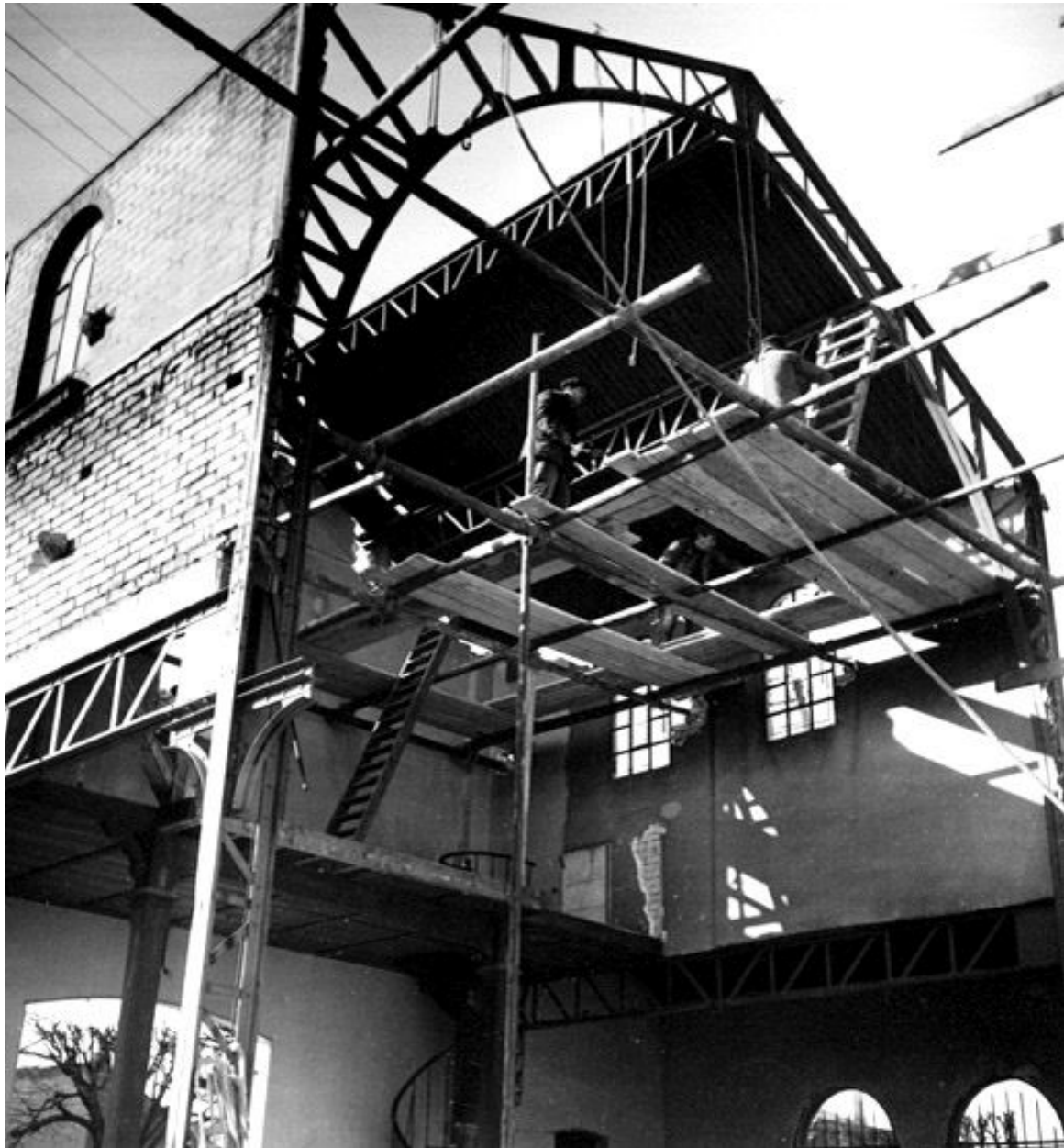
Eglise paroissiale Sainte-Marie Libératrice du Plant, 25 rue Maurice Piroley. Vue rapprochée de la démolition révélant la structure métallique de l'ancienne chapelle. Photographie. (Association des Chantiers du Cardinal)
