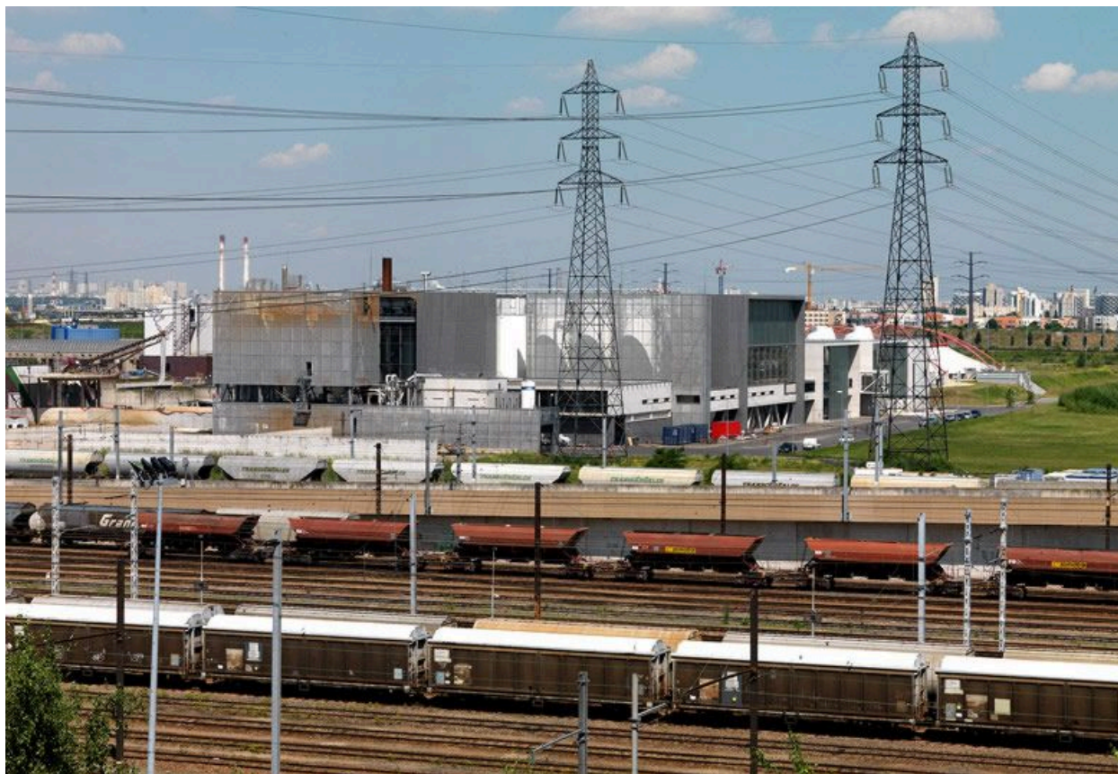
Valenton, gare dite chantier multitechnique de Valenton. Vue générale.
