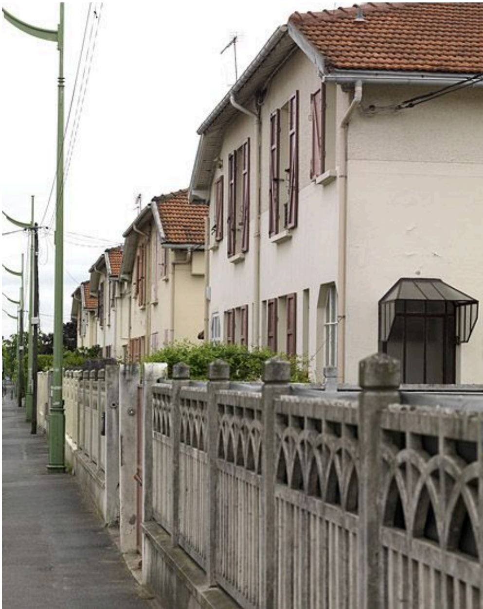
Vitry-sur-Seine, lotissement concerté, rue Victor-Ruiz . Alignement des maisons jumelles de ce petit lotissement construit pour le personnel d'EDF/GDF (?).
