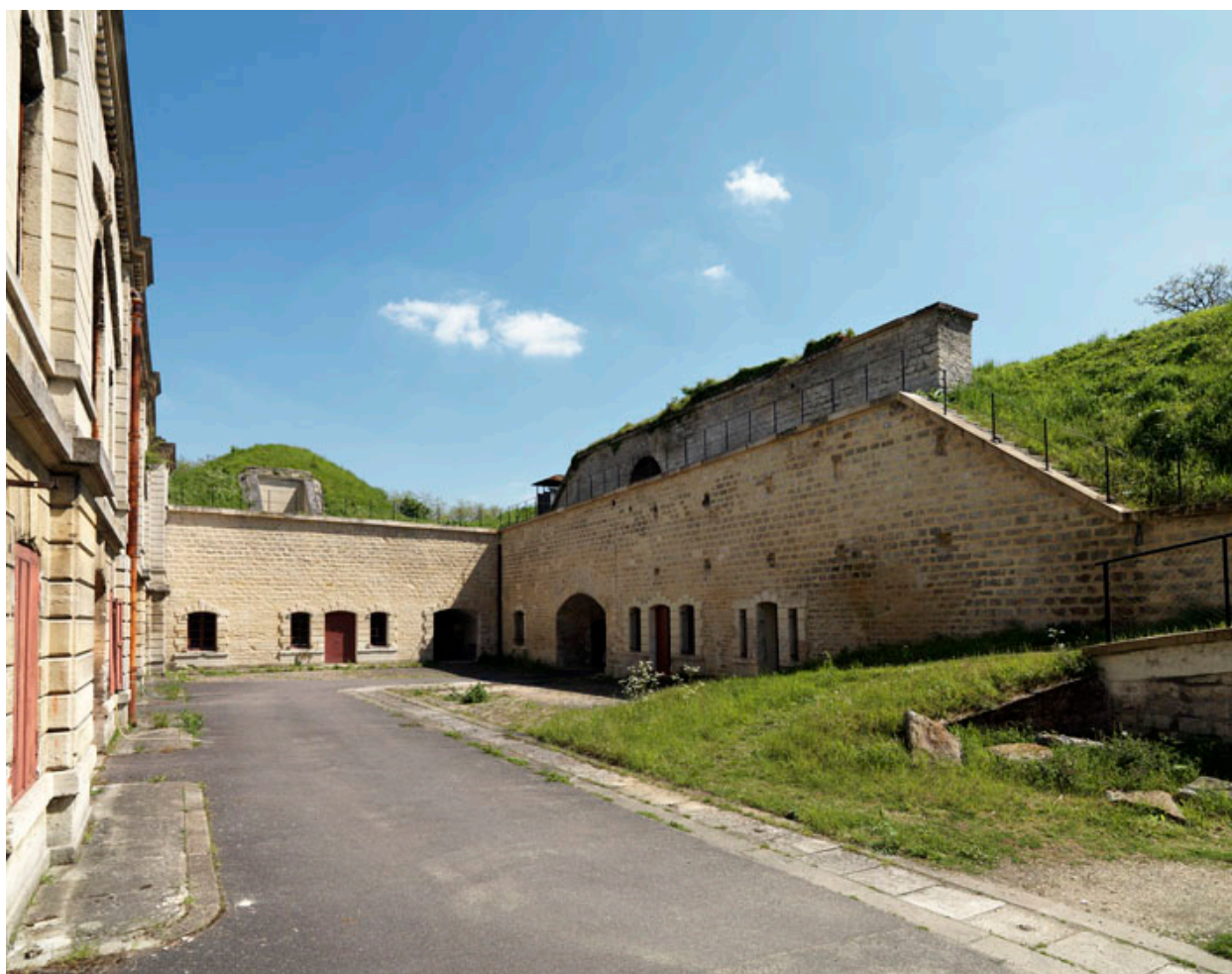
La cour de la caserne, vue prise depuis l'ouest.
