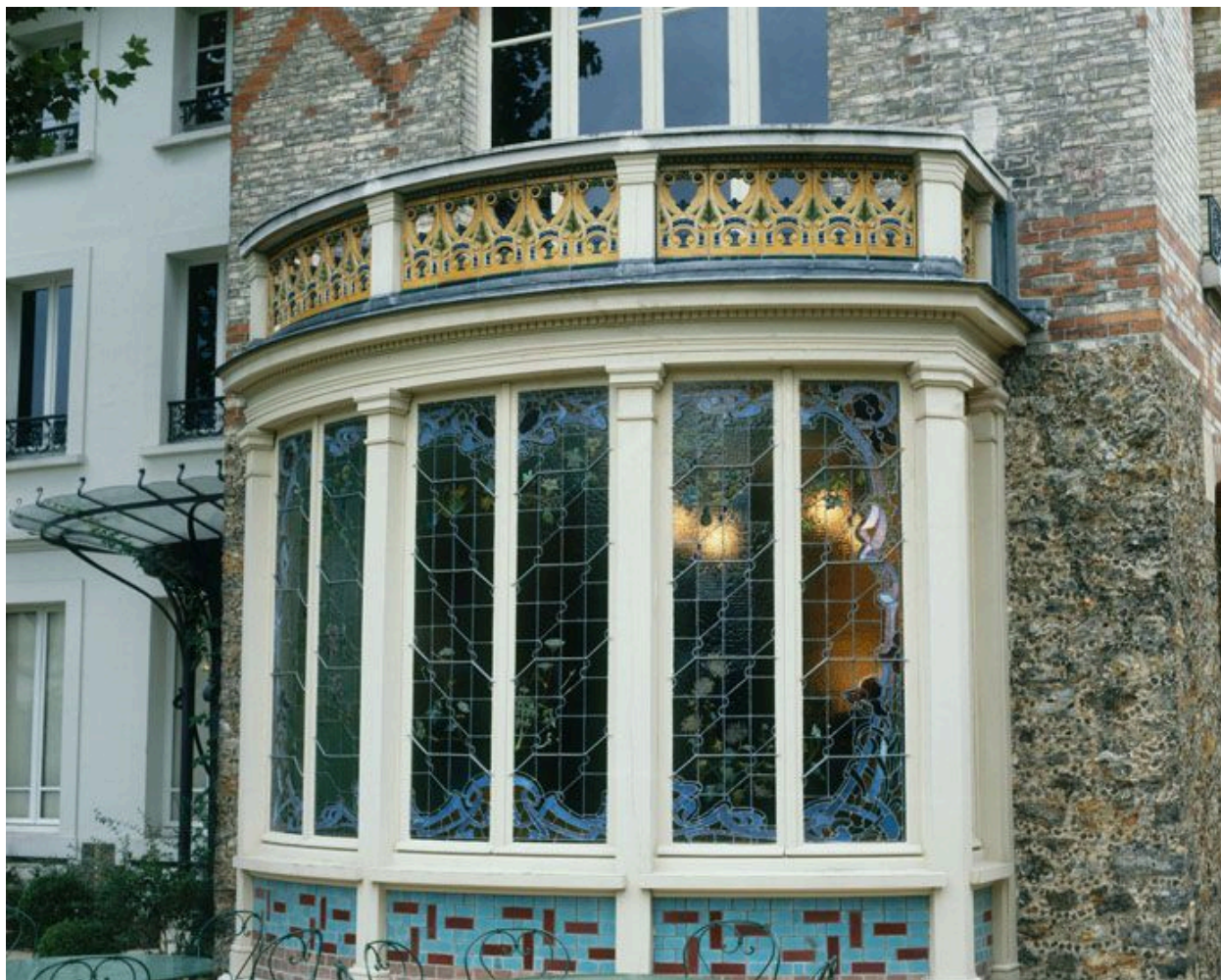
92 - Asnières-sur-Seine, maison d'industriel dite maison Vuitton, 16 rue du Congrès.
