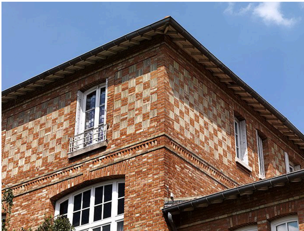
92, Gennevilliers, école primaire dite groupe scolaire Pasteur, 60 rue Richelieu Richelieu. Détail de l'appareil en damier polychrome de la façade antérieure de briques.
