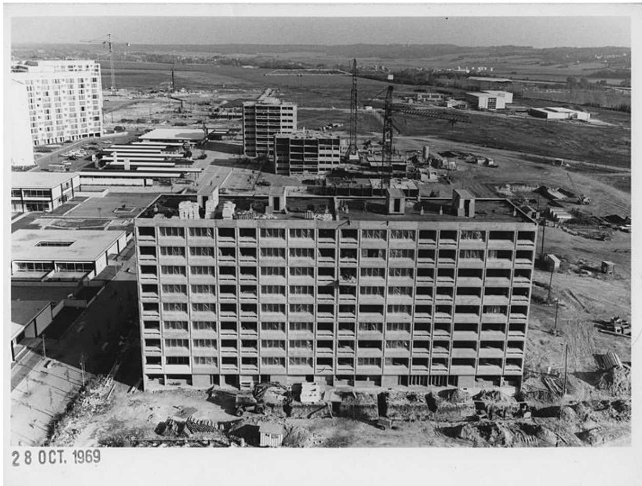
Chantier de la construction - Mise en place des grues sur rail et achèvement de l'élévation des barres de Beauval. Vue de l'école primaire et du collège C10 octobre 1969. (OPAC Meaux)
