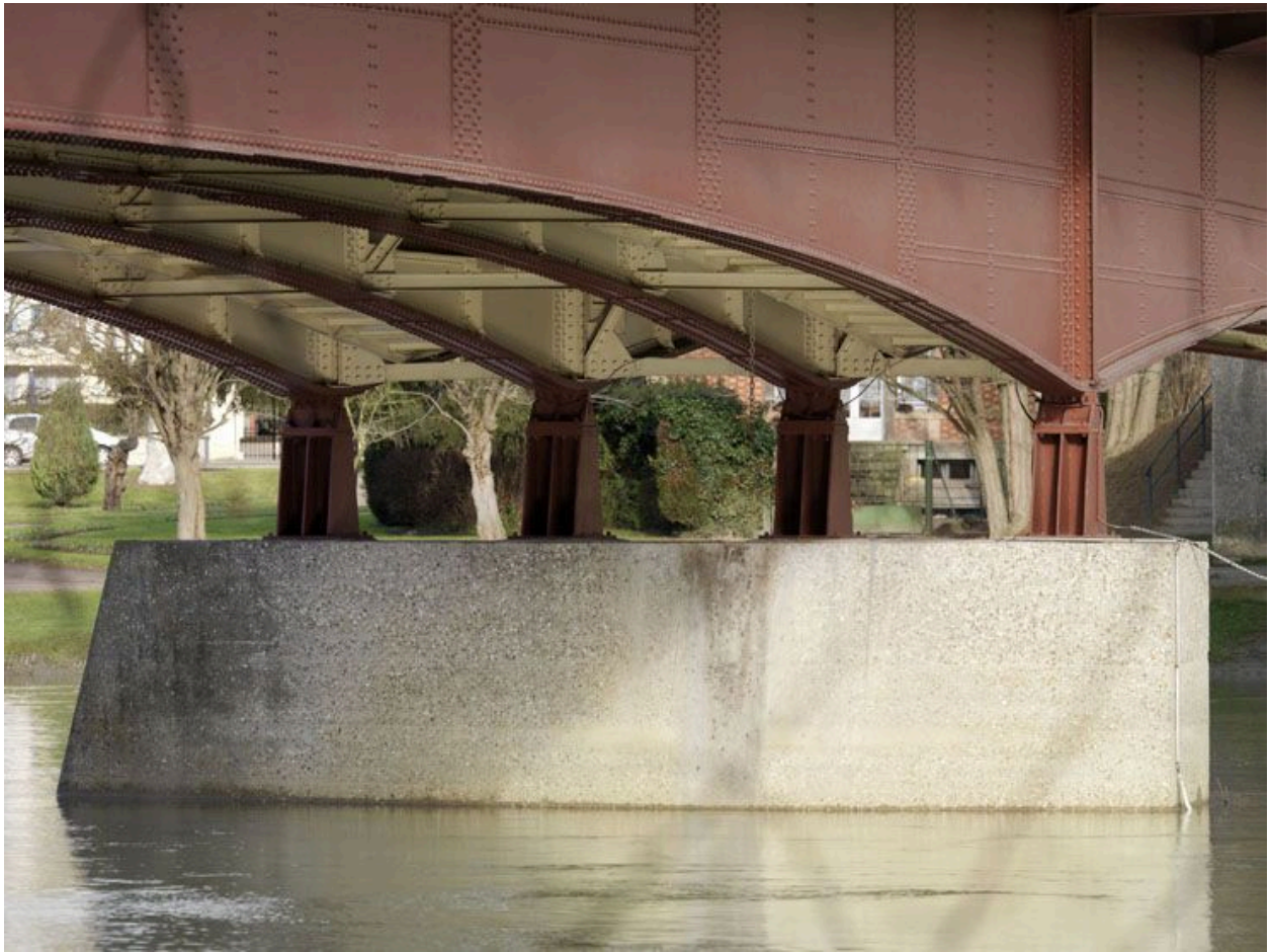
Meulan : sous le tablier du pont de Meulan depuis l'île Belle.
