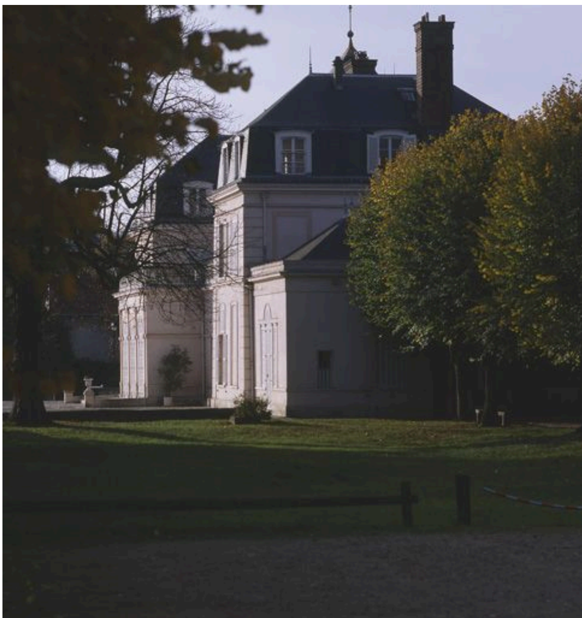
Vue de la façade latérale nord, derrière les tilleuls du "cloître".
