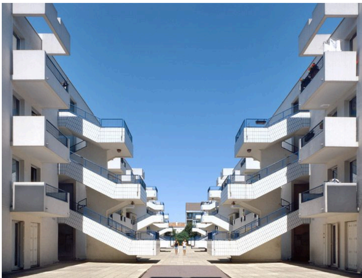
Immeubles dits de la Grande Prairie, 174-180 et 159-161 rue Diderot. Opération de logements sociaux réalisée en 1986. Vue d'ensemble de la première cours intérieure. Kalisz, Jacques (architecte)
